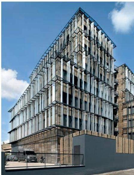
L'immeuble Perspective présente une structure poteaux-poutres en bois lamellé-collé en pin des Landes, agrémentée d'un bardage en épicéa du Limousin. Il constitue une véritable vitrine pour la filière bois en France (Nicolas Laisné et Dimitri Roussel, architectes).
