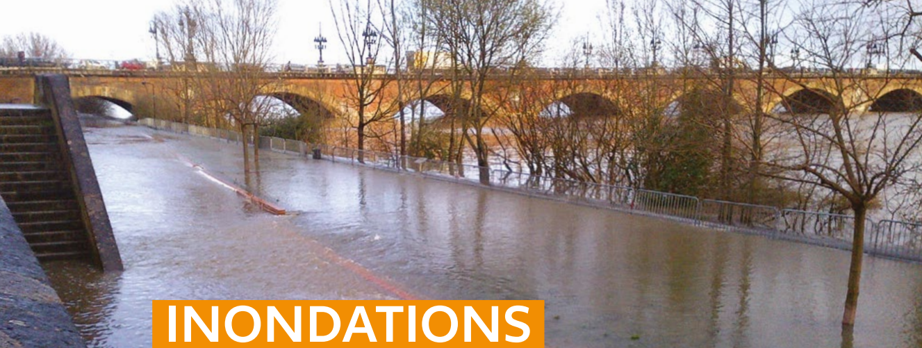
Inondation de la Garonne - Mars 2014 ©EPA
