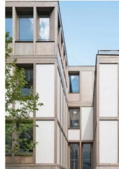
Enduit à la chaux C Vergely
