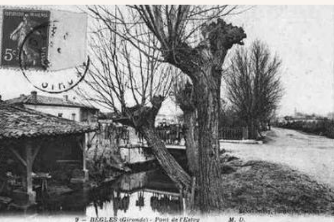
Bègles - Pont de l'Estey
