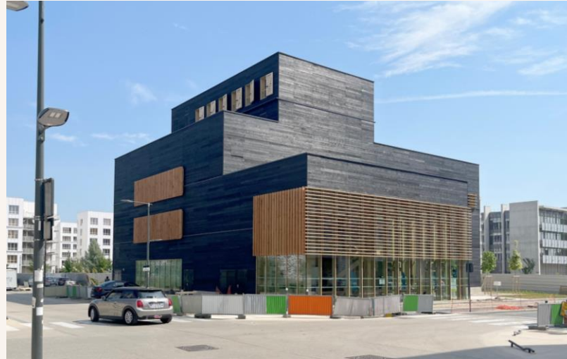
Bardage bois - Jean-Marie Duthilleul
