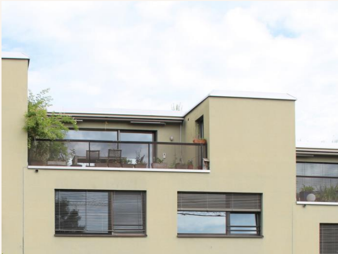
Le duplex avec la terrasse dans le ciel Zurich, Zita Cotti arch.
