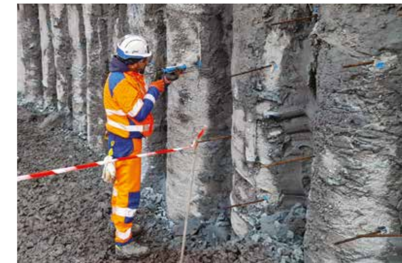
Chantier de la Trémie Benaige © Christophe Hans
