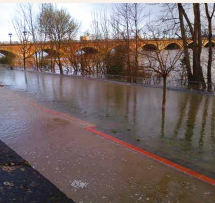
Inondation de la Garonne, 2014 © Bordeaux Euratlantique
