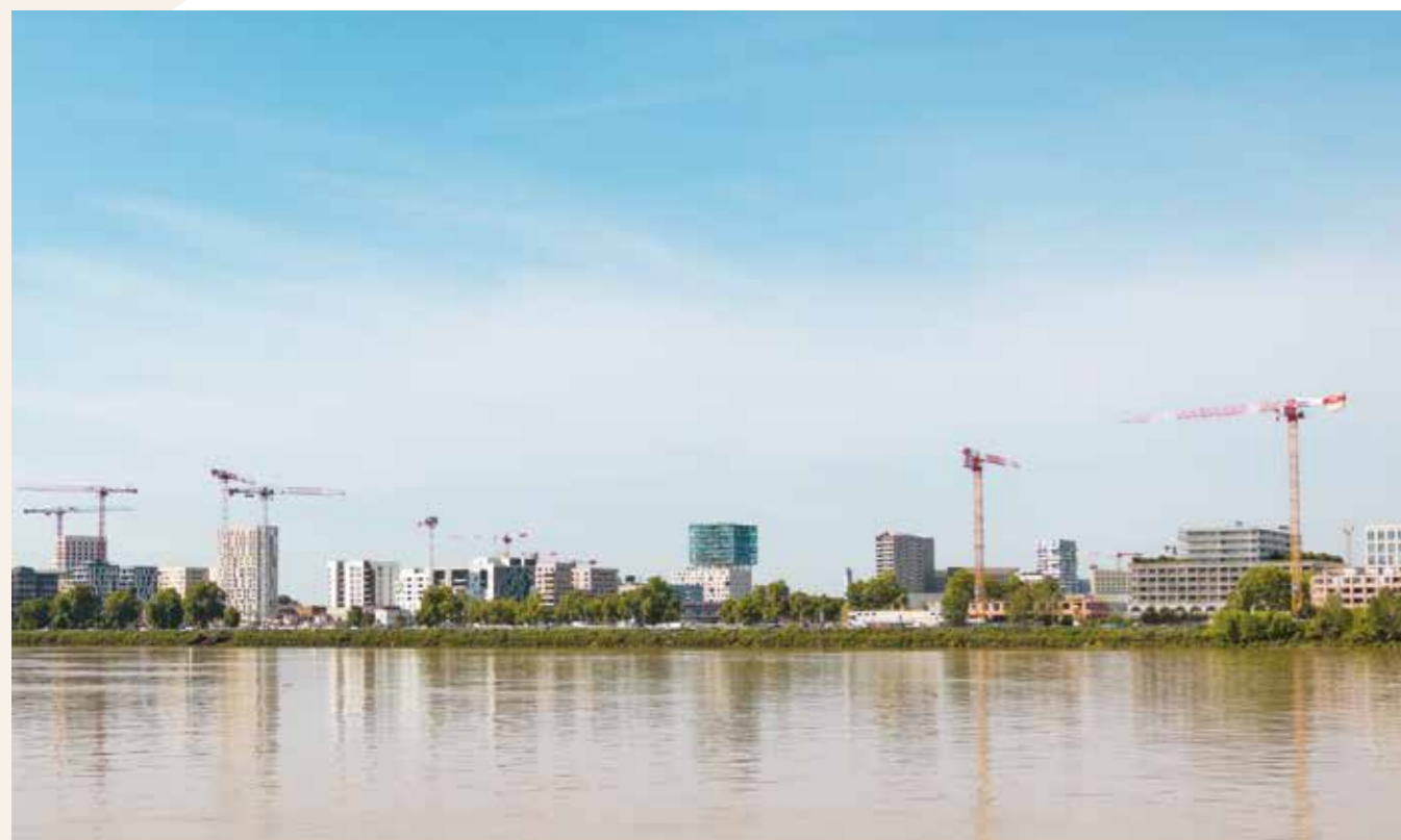
Vue des berges de Garonne © Rémy Pujol
