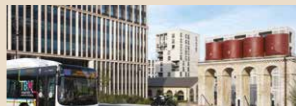
Siège de la Caisse des Dépôts et Consignations © Rémy Pujol
