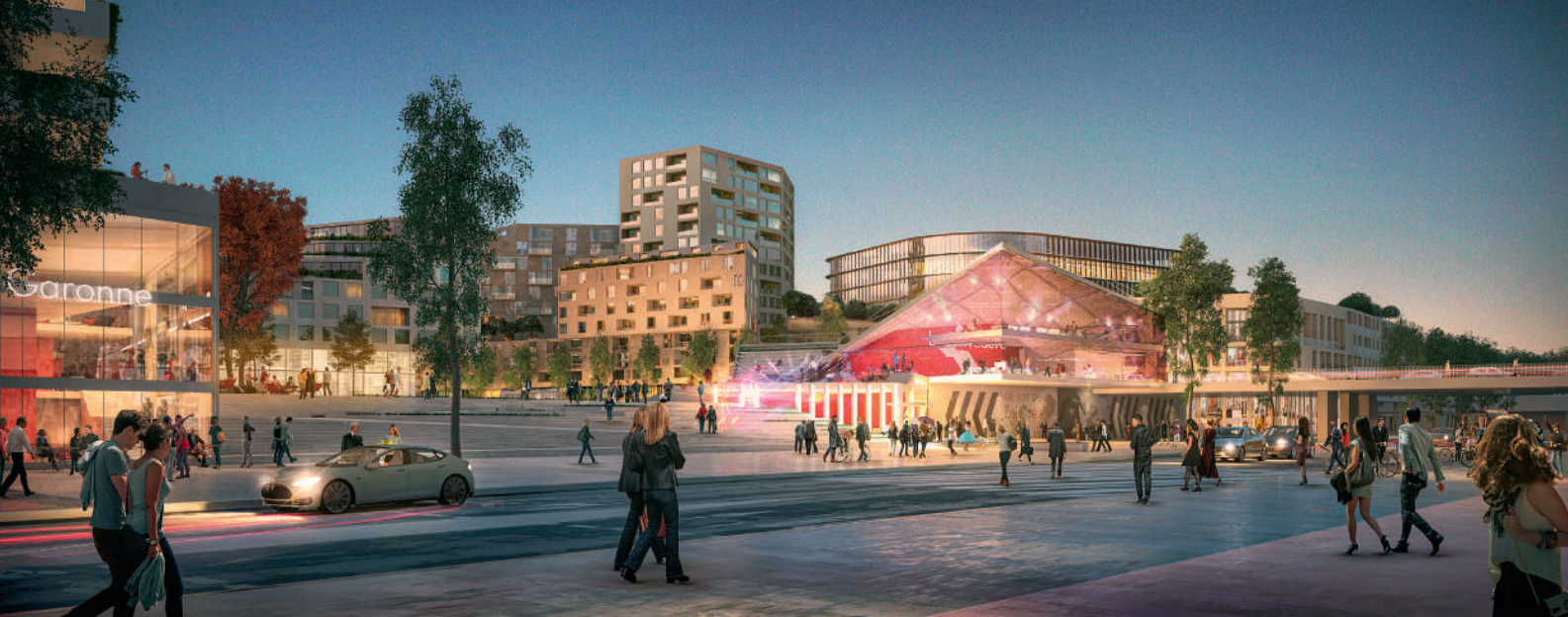
Le quartier Deschamps-Belvédère, dont les travaux débutent, s'inscrit dans la première phase de la ZAC Garonne-Eiffel et constituera le trait d'union entre la rive droite et la ville de pierre.
