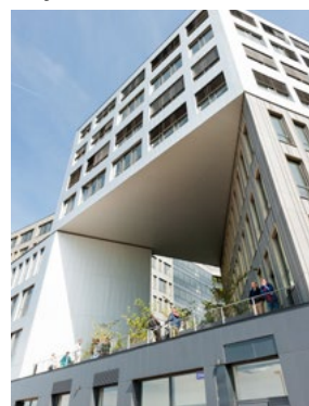
Bureaux de l'ensemble Quai 8.2
