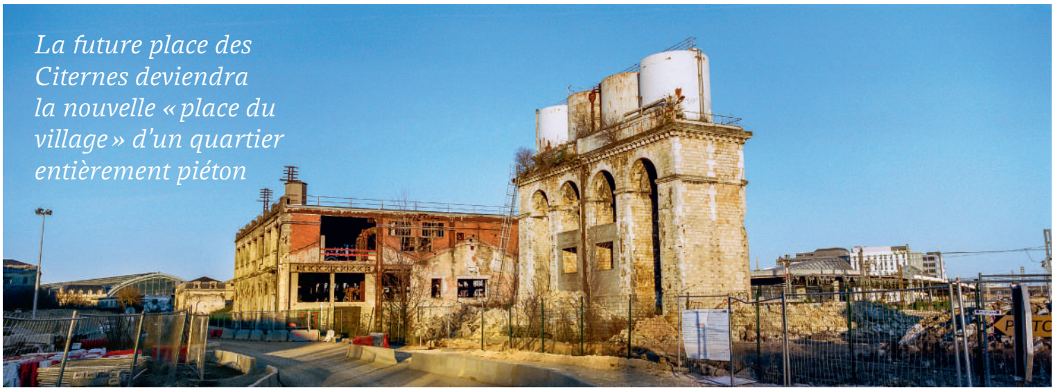
Ancien château d'eau des ateliers ferroviaires de Bordeaux Saint-Jean, rebaptisé « les citernes ».
