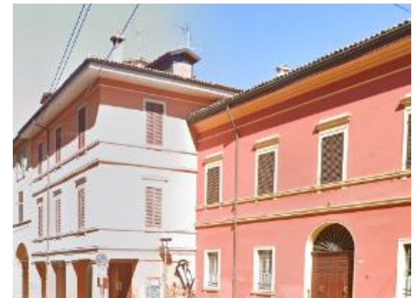
Débord de toiture Rue Parigi
