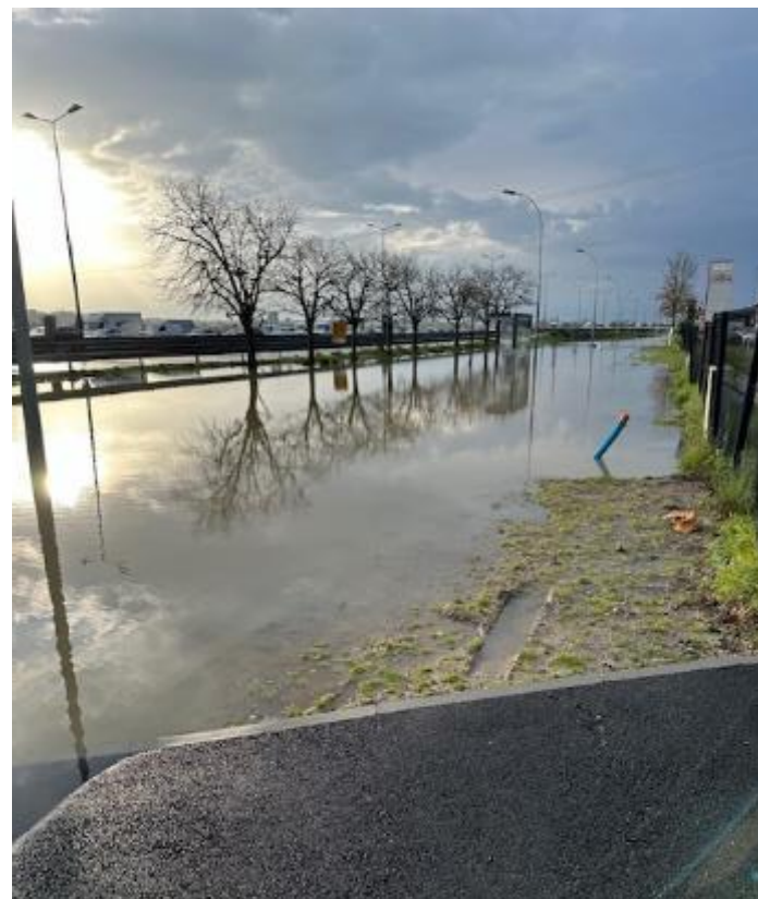
Inondation quai Wilson 20/03/2024
